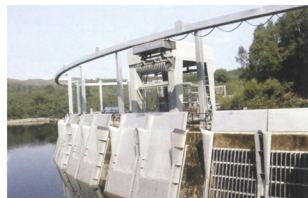
运行中的HYD2000型移动式抓斗格栅除污机
